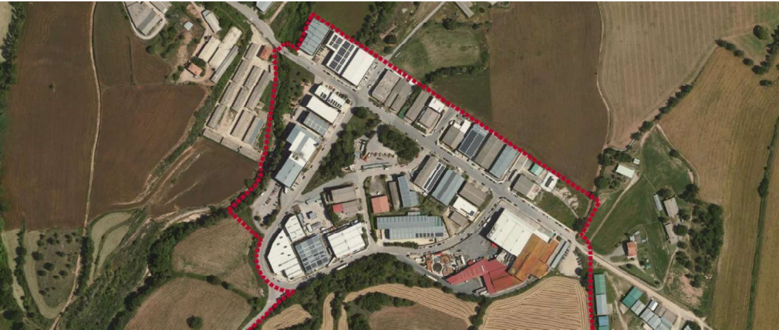
Ortofoto de l'estat actual del polígon industrial del Prat [vegis plànol i.04]
